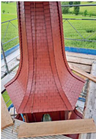
Die neuen Schindeln des Glockenturms.
