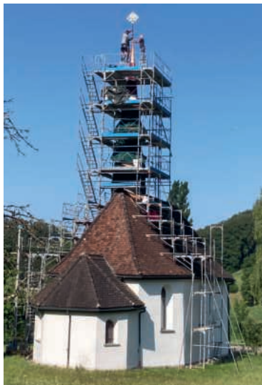
Die Abschlusspitze wird montiert.
